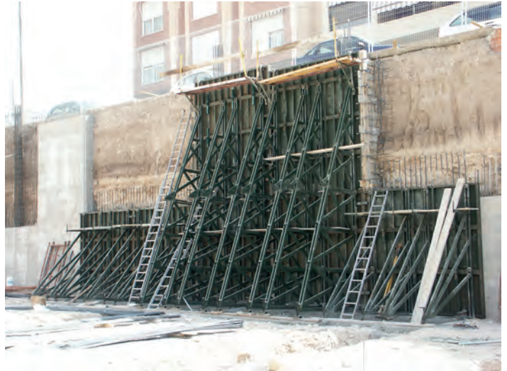
ENCOFRADO PARA MUROS | WALL BRACED ON ONE SIDE | MUR COFFRÉ SUR UNE FACE COFRAGEM PARA PAREDES
